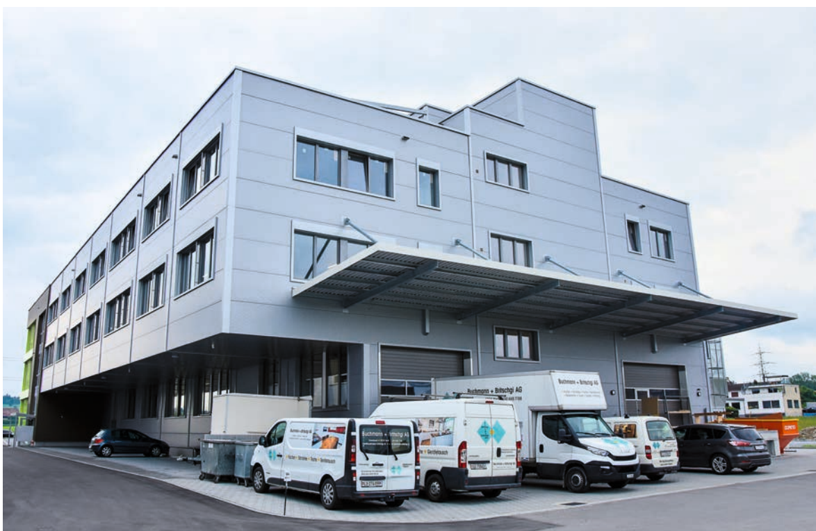
An der überdachten Rampe gibt es je ein separates Tor für die Anlieferung und die Spedition.
